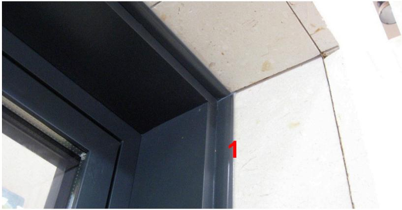
iii. entre la baguette de finition du dormant et le revêtement extérieur du mur une fois posé, par un 2<sup>ème</sup> scellement au silicone (1).
