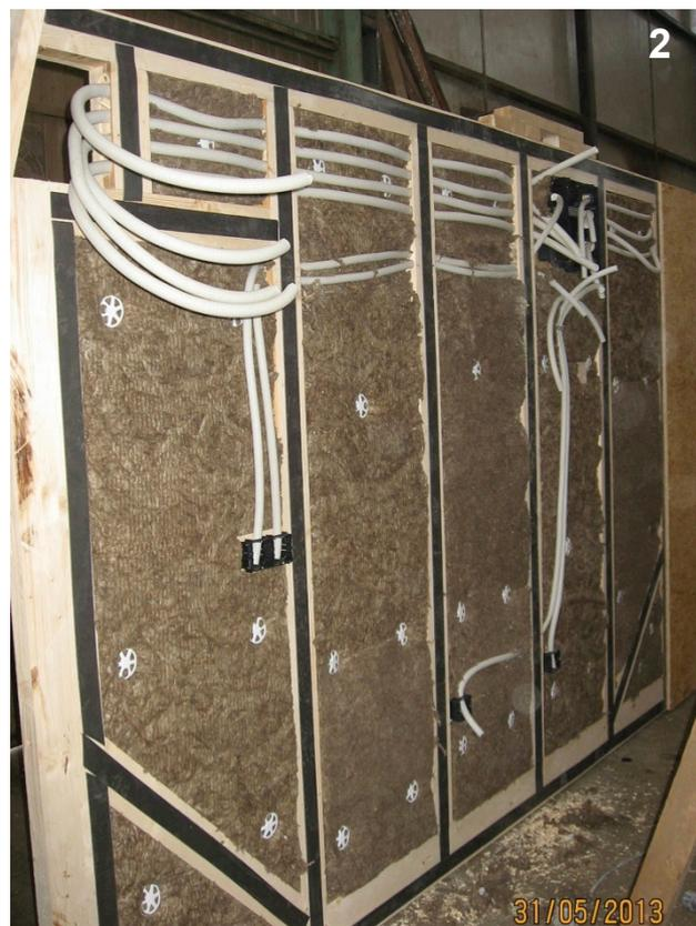
Pour le matériel électrique, les pieuvres sont préinstallées également dans les murs (3) :
