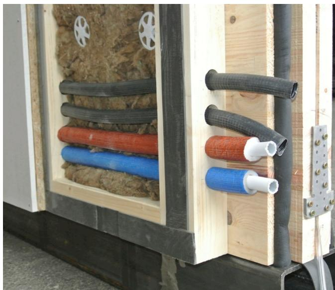
Afin de maintenir une parfaite étanchéité, l'ensemble des gaines techniques sera équipé de manchons ad hoc pour traverser le pare-vapeur.
